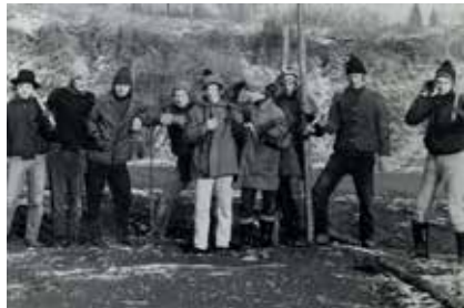
Plocení staveniště Jednoty (1973)
