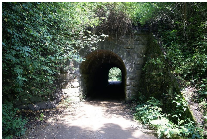
Foto č. 13 - Tunel
