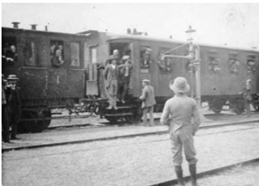
Odjezd zmobilizovaných z postupického nádraží v září 1938
