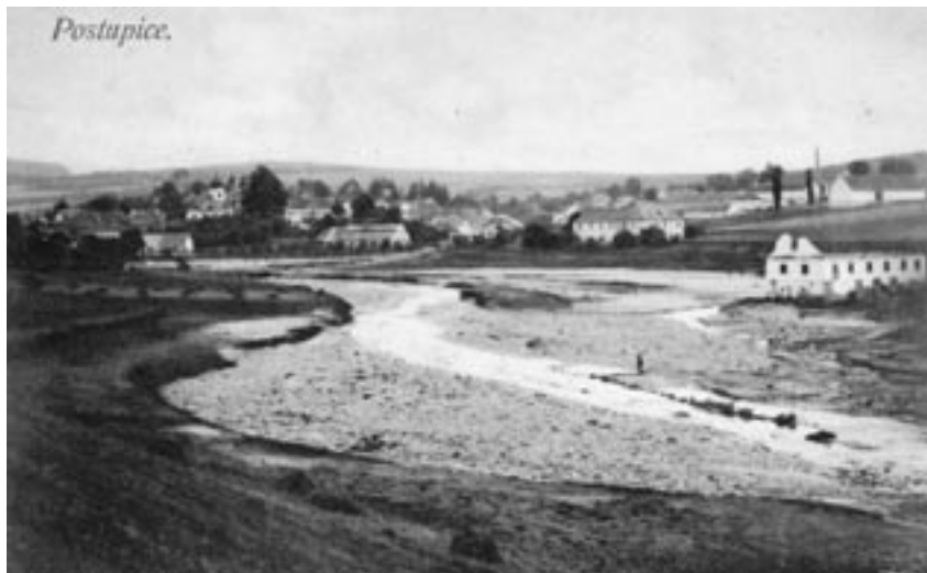
Plajchy zdevastované povodní - Vpravo po povodni zbouraná budova „Pejchovny“. Stála v místě dnešní branky fotbalového hřiště a cesty k čistírně.
