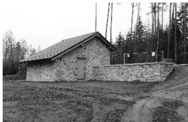
Vodojem v Zálesí
