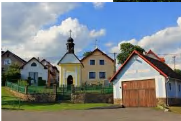
Kaplička se samostatným prostorem a zvoničkou, zdroj „Chopos“
